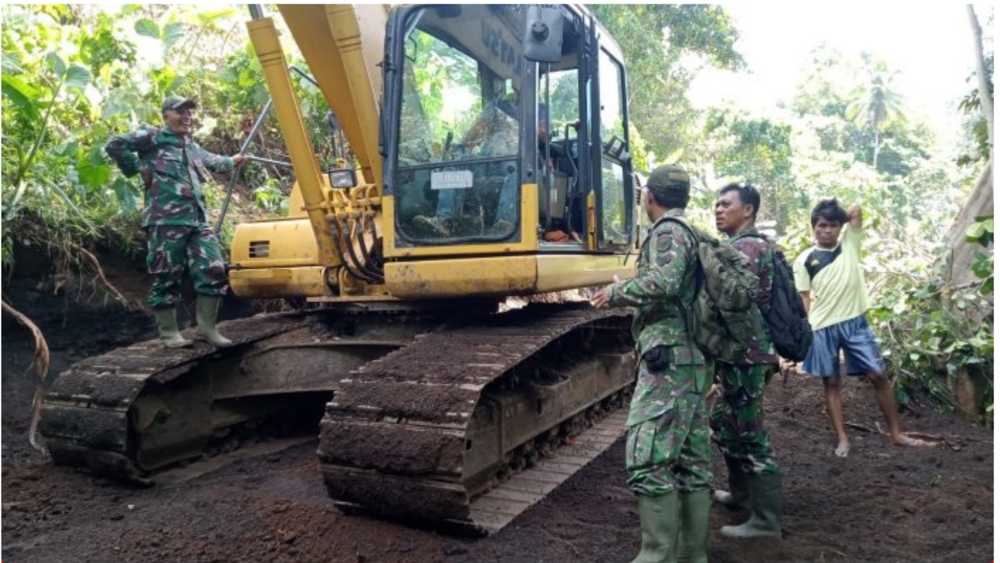
Ribtisan Jalan Pertanian pada TMMD Ke-116 Tahun 2023 Kodim 1310 Bitung
